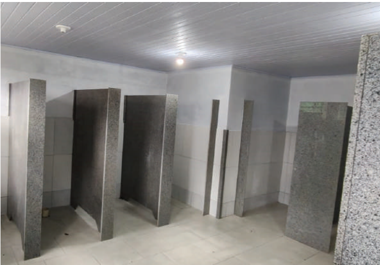
Área interna dos banheiros centrais femininos do Parque de Exposições
