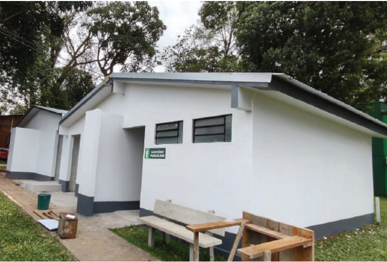
Obra de ampliação e reforma dos banheiros próximo a entrada do parque está em fase final de conclusão
