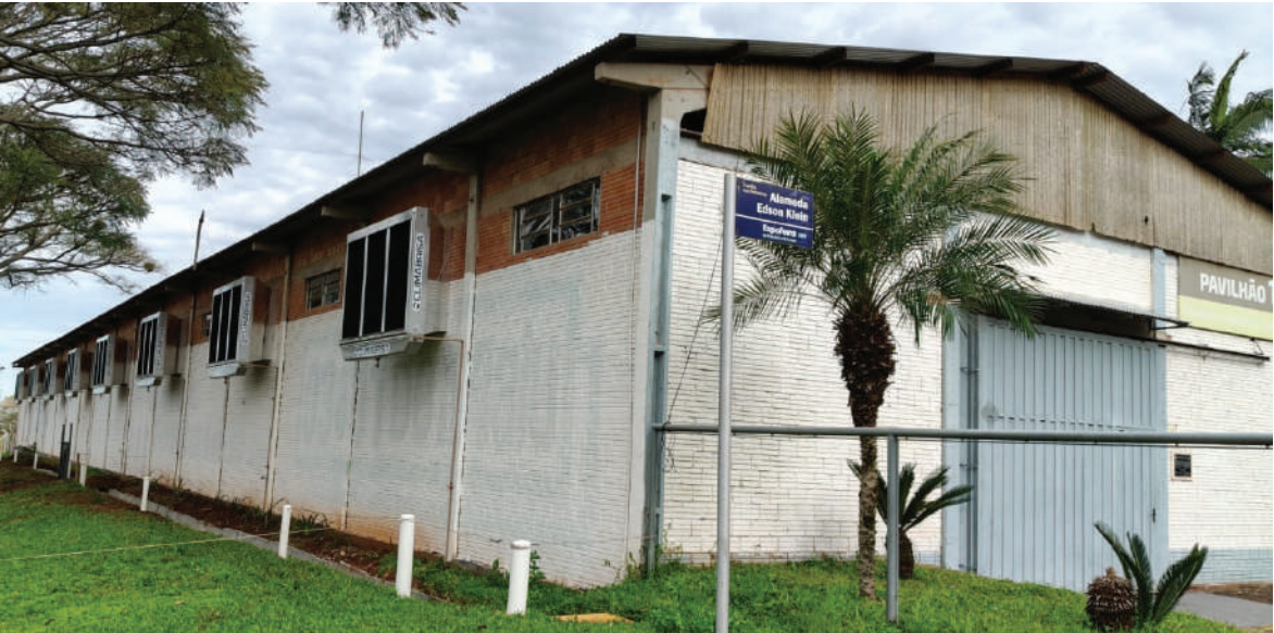
Pavilhão 1 recebeu oito climatizadores para trazer conforto térmico para expositores e visitantes
