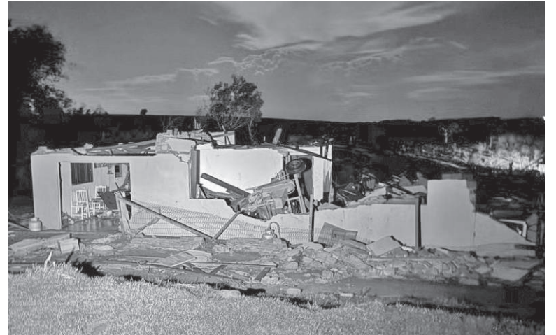
Em Sete de Setembro, o tornado causou a destruição completa de casa e galpões
