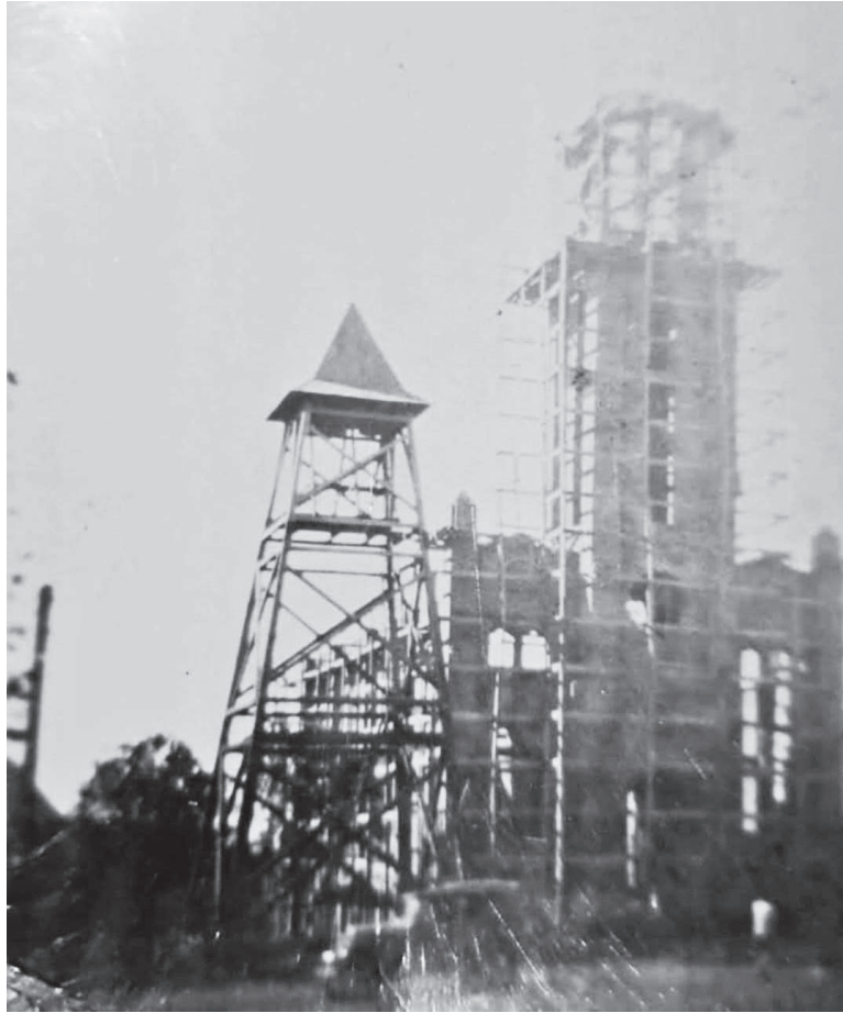
As obras de construção da nova igreja da Comunidade Evangélica de Confissão Luterana São Paulo (IECLB) de Três de Maio duraram dez anos e contaram com o apoio de toda a comunidade
