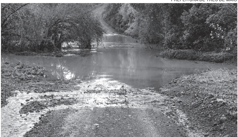
Ponte sobre o Lajeado Tigre teve o trânsito interrompido entre Nossa Senhora Navegantes e Nossa Senhora Dores
