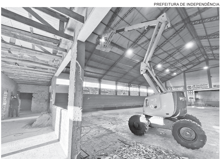
O projeto contempla a substituição da cobertura por telhas termoacústicas, a recomposição dos pisos, a manutenção das esquadrias, das instalações elétricas e hidrossanitárias e serviços de pintura
