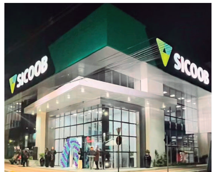
O Sicoob inaugurou na última sexta-feira (3) a sua sede própria em Três de Maio, na presença de convidados, autoridades e cooperados. A nova sede, com 1.500m², com uma arquitetura moderna, oferece mais comodidade aos colaboradores e para todo o quadro de associados. Parabéns a direção da cooperativa por acreditar no potencial de Três de Maio e região.
