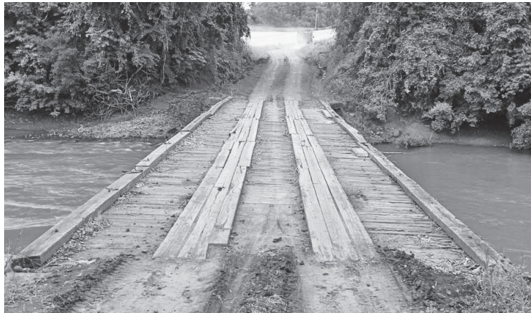
Ponte de madeira sobre o Rio Inhacorá, entre Linha Jundiá e Bom Princípio, será substituída por uma infraestrutura de concreto
