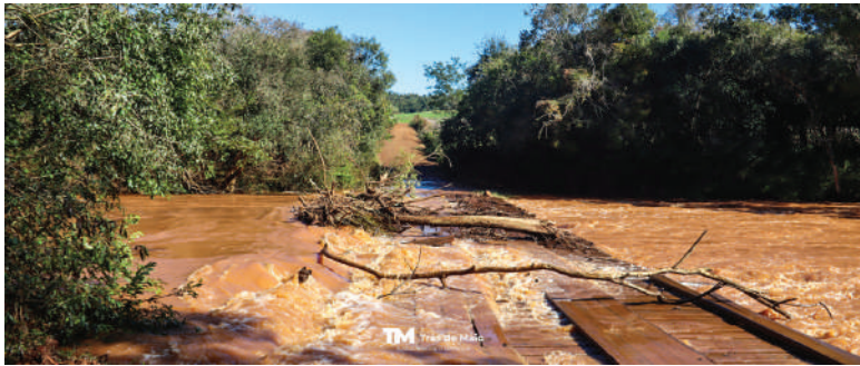
Em Três de Maio, tráfego sobre a ponte do Rio Santa Rosa, em Nossa Senhora Auxiliadora, foi interrompido devido ao nível a água e os galhos trazidos pelas
