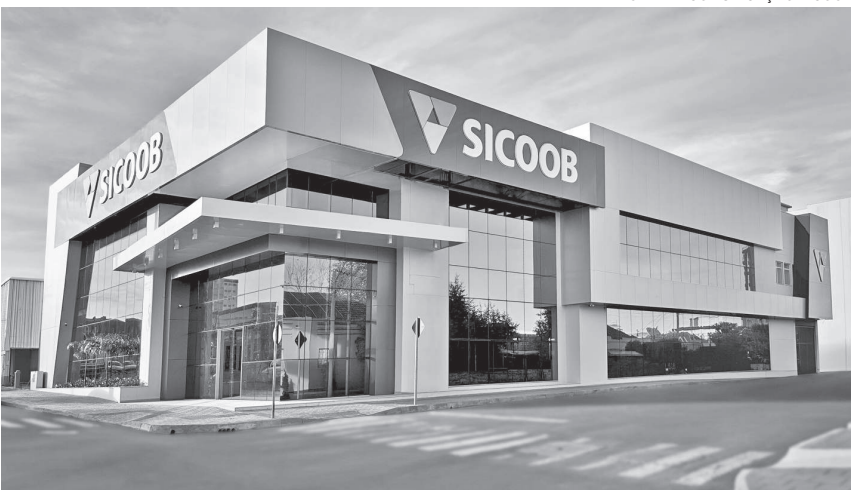
Novo prédio tem cerca de 1.500 metros quadrados de área construída e fica localizado no cruzamento das ruas Horizontina e São Paulo
