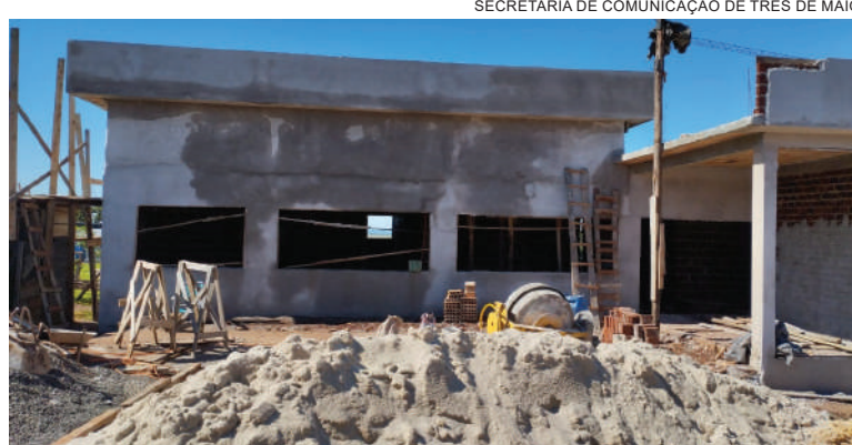
Próximas etapas da obra incluem o acabamento, com reboco interno e externo, arremates, esquadrias, parte hidráulica e elétrica, pintura e piso
