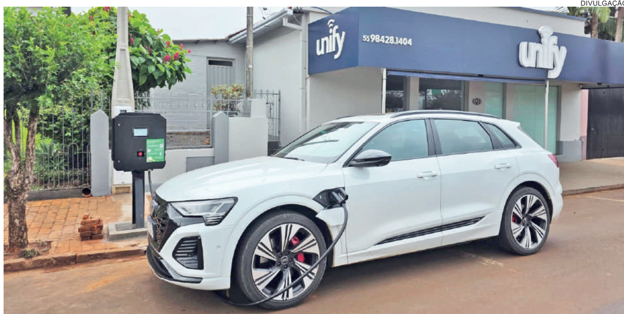
Recarga de veículo elétrico em eletroposto reflete o avanço da infraestrutura de mobilidade sustentável e a crescente adoção de tecnologias de baixa emissão de poluentes
