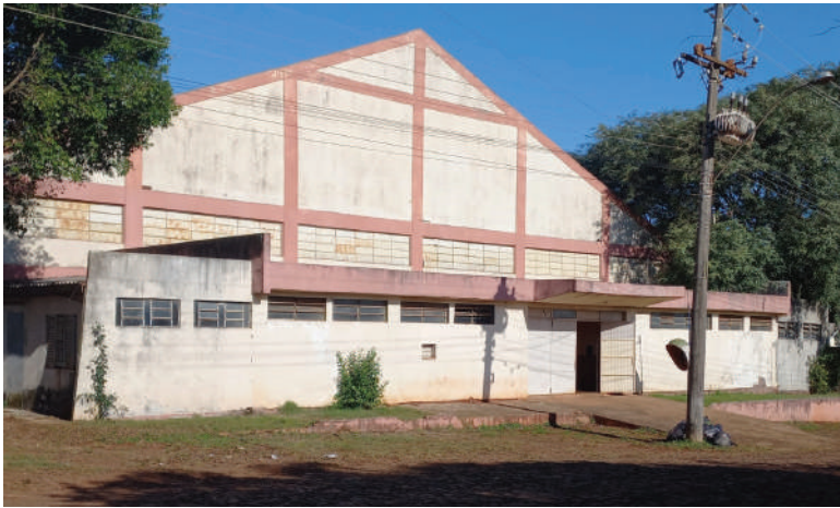
Intervenções incluem a substituição do telhado do ginásio e manutenção de pisos e instalações elétricas e hidrossanitárias
