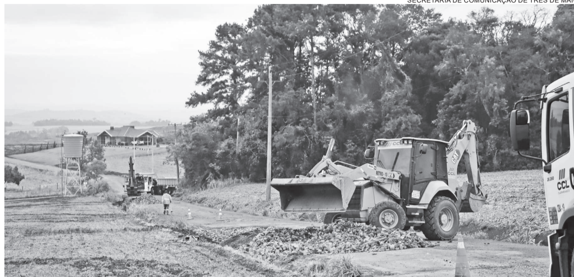
Investimento superior a R$ 4 milhões contempla recuperação do asfalto, nova camada asfáltica, sinalização, pintura e limpeza das margens da rodovia
