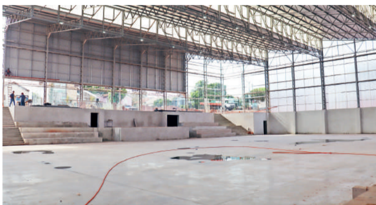
Na fase atual a obra avança para os ajustes finais, que incluem pintura, finalização de pisos e acabamentos
