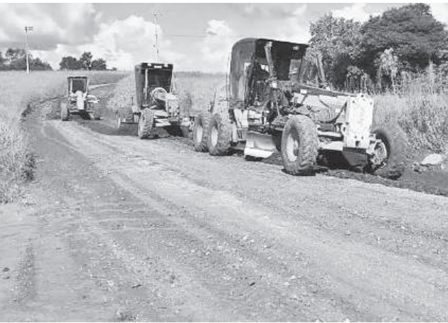
Estrada recebeu patrolamento, melhorando a trafegabilidade
