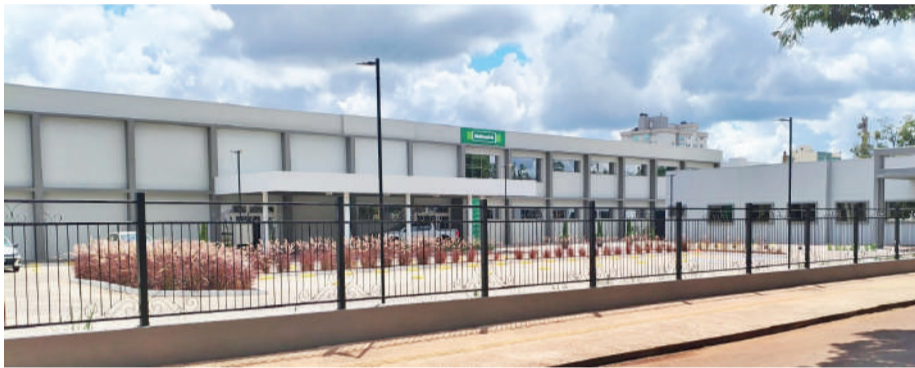
A nova sede da Unimed Alto Uruguai está na Avenida Avai, 370, em um prédio amplo e moderno
