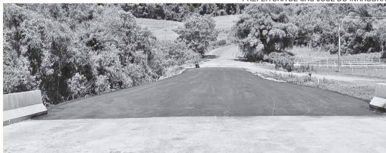
A obra é fundamental para melhorar a infraestrutura local, facilitando o tráfego e a mobilidade
