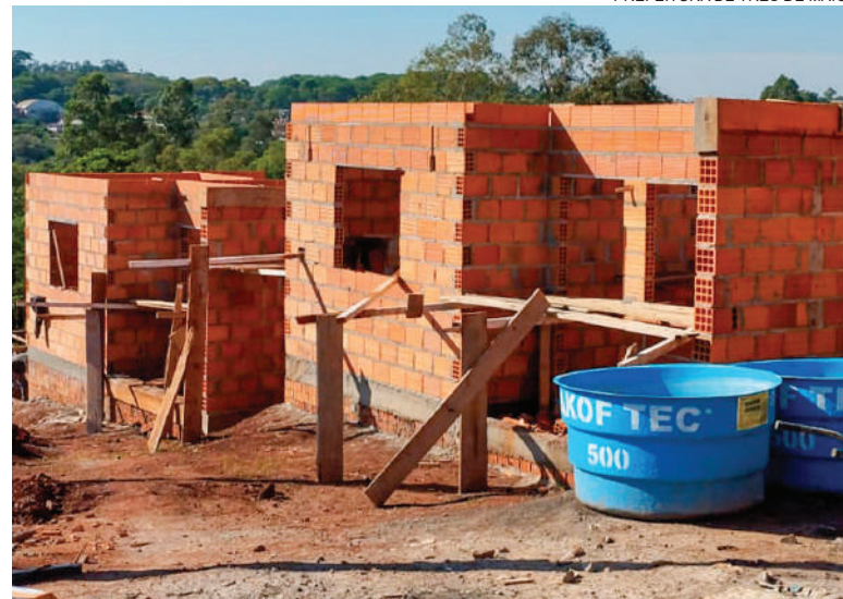
Residências de 50,28 metros quadrados serão compostas por dois dormitórios, banheiro, sala, cozinha, lavanderia e varanda
