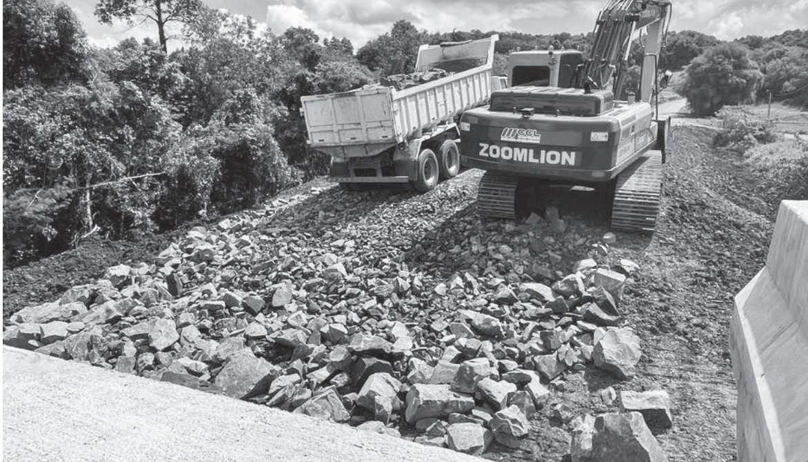
Ligação entre a ponte sobre o Lajeado Cachoeira e a AM 9115 foram retomadas na semana passada e devem ser concluídas até o fim do ano
