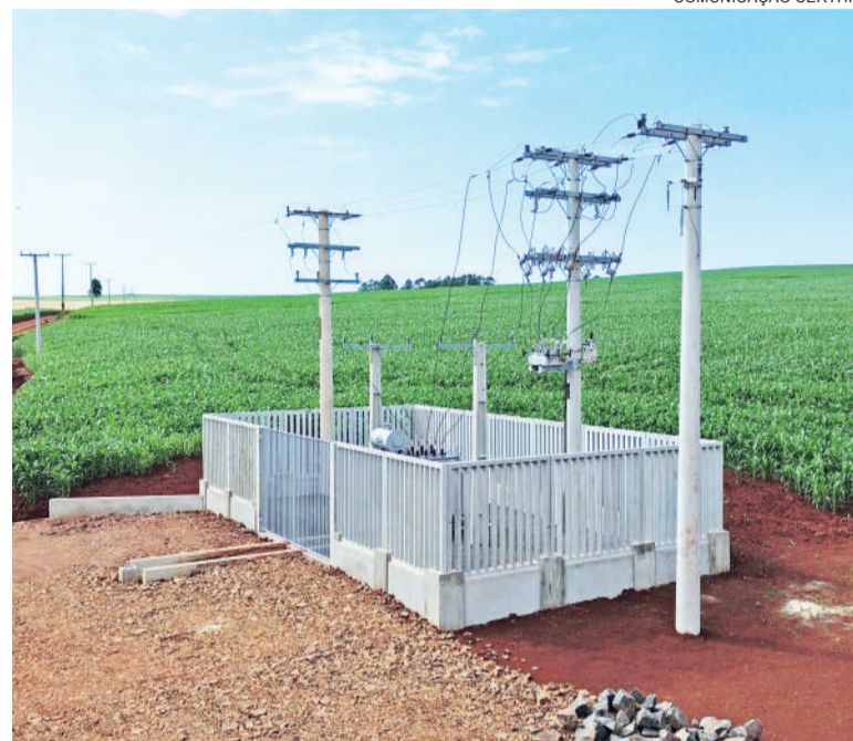
Subestação rebaixadora de 25 para 15 Kv, terá 5 MVA de capacidade
