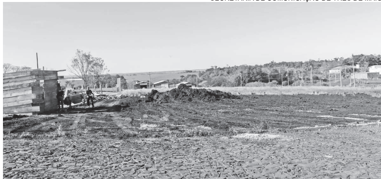
Obra está sendo realizada ao lado do Memorial Saúde, no bairro Planalto
