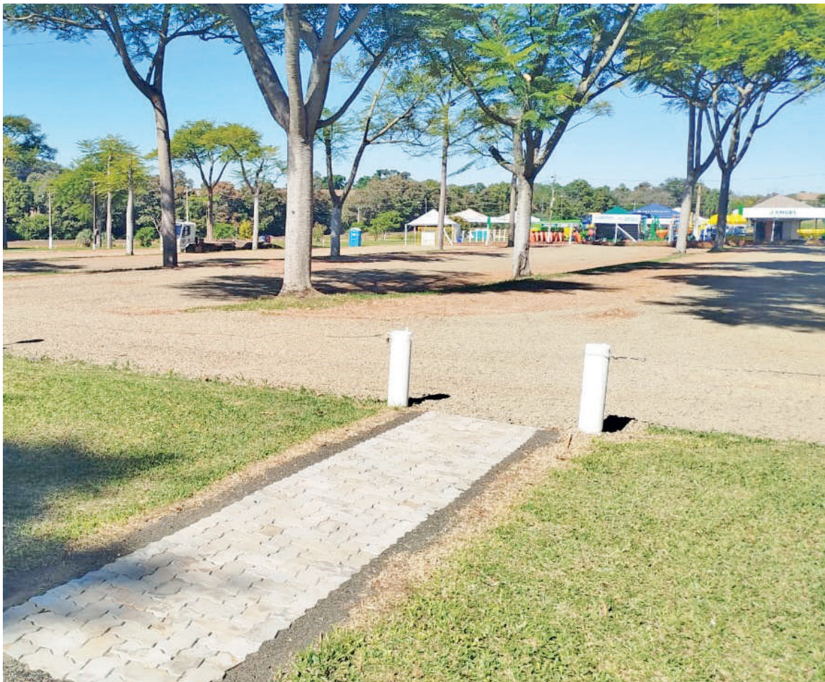
O estacionamento na área frontal do parque, que ficava muito prejudicado em dias de chuva, recebeu melhorias
