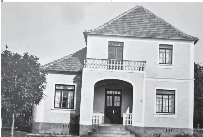
Residência e gabinete dentário de Albino Rieck, localizado na área mais central de Flor de Maio
