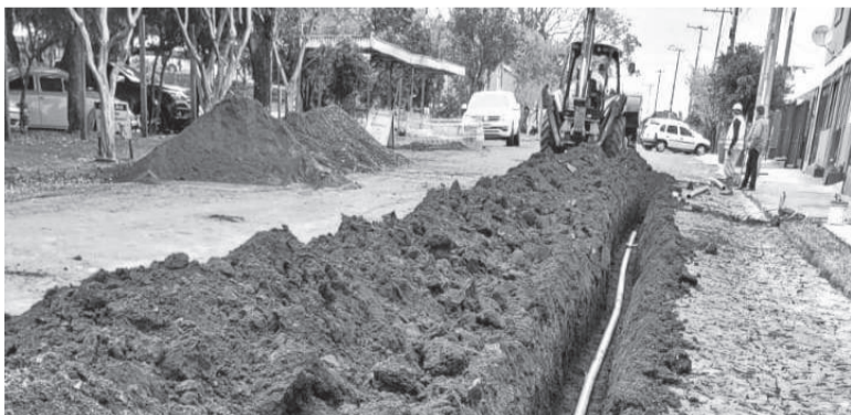
Foram feitas a substituição encanamentos de fibrocimentos por tubos de PVC
