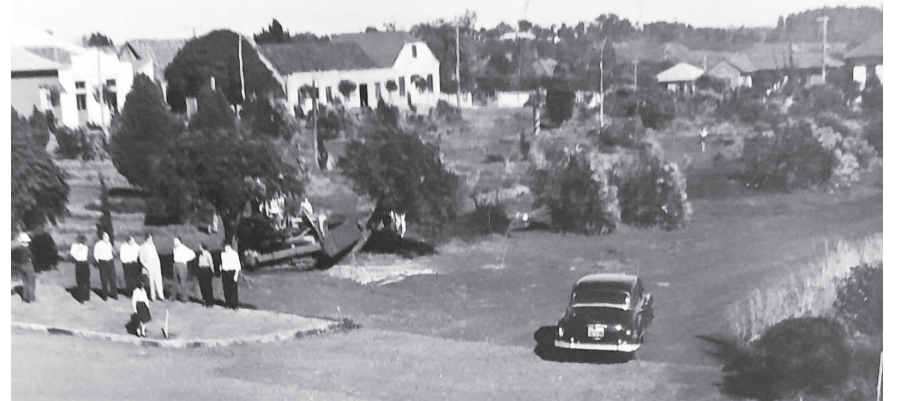
Julho de 1959. Início das obras de infraestrutura da Praça da Bandeira durante a administração do prefeito Walter Ullmann. Na imagem, carro entrando na atual Rua Alcyr Ramos Tomasi
