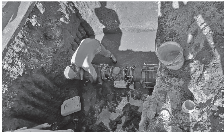
Equipamento possibilita a comparação entre o volume de água que sai da rede de distribuição e o que chega aos imóveis
