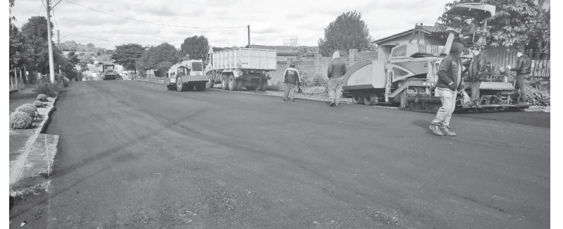
Trecho da Rua Senador Pinheiro recebeu capeamento asfáltico
