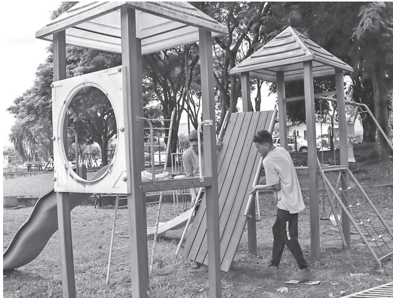
Equipe realizou a retirada dos brinquedos que serão reinstalados após a conclusão da obra
