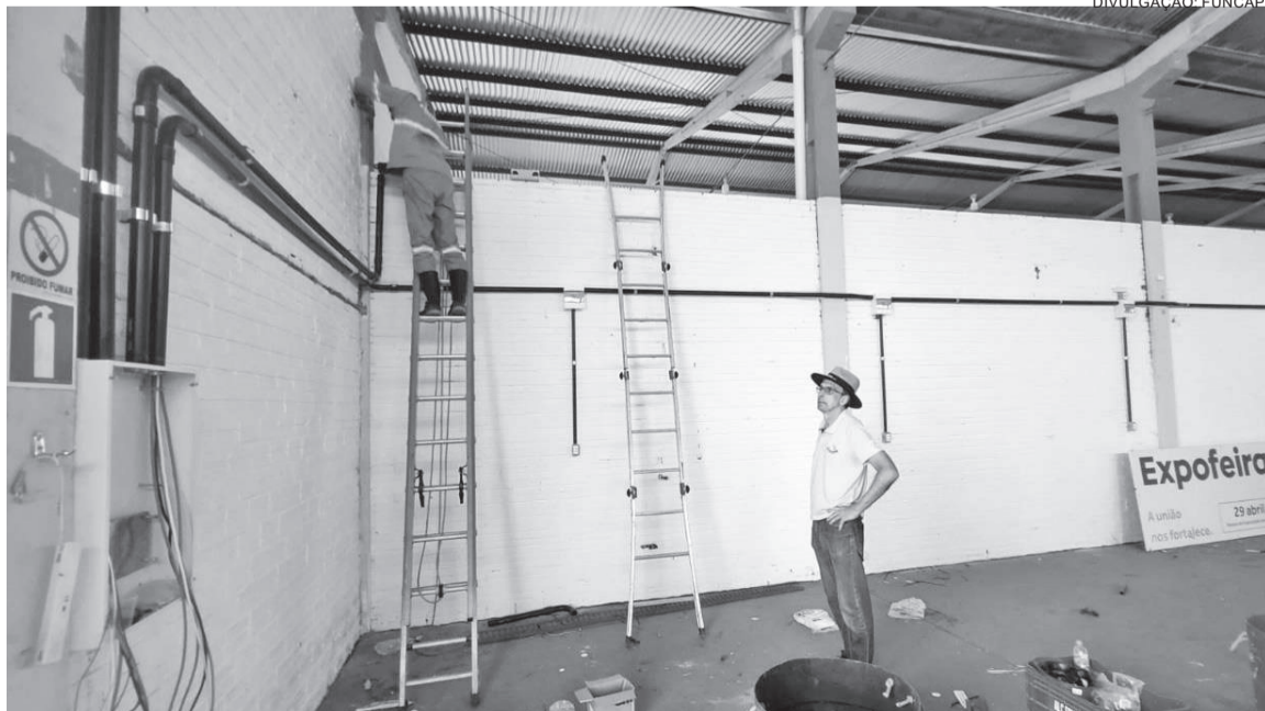
Obra no Pavilhão 3 do Parque de Exposições visa trazer segurança e conforto aos expositores e visitantes na Expo Terneira 2024
