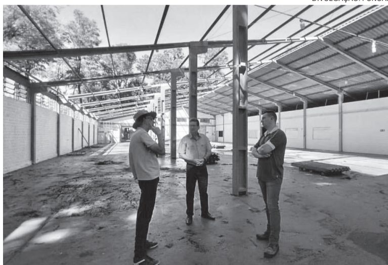
Novo telhado será de aluzinco, material com mais durabilidade
