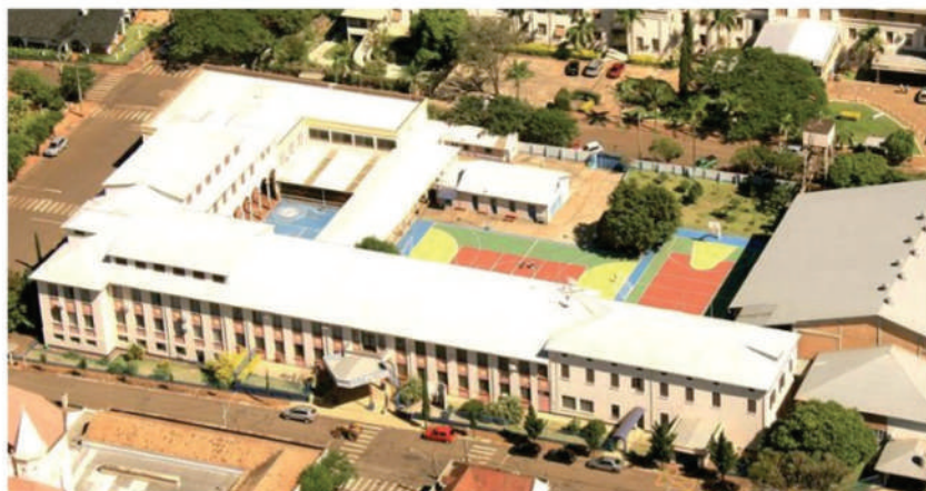
Foto: Estrutura do Colégio Dom Hermeto.
