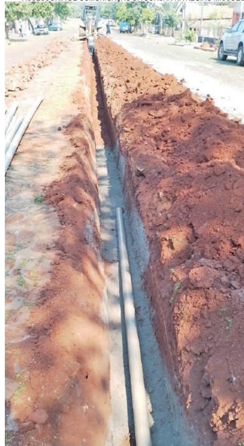
Novos ramais e canalizações no Bairro São Francisco e Oriental vão melhorar o abastecimento de água
