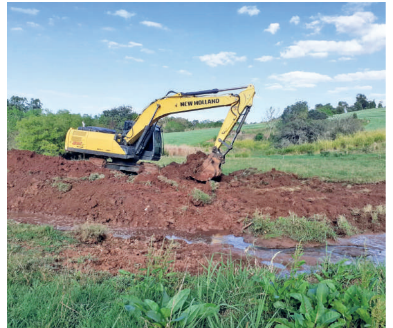
Obras de construção de microaçudes iniciaram no dia 25 de agosto. Previsão é de que sejam concluídas em 120 dias
