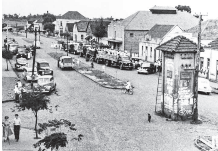
Local onde estavam instaladas as chaves do disjuntor que fornecia energia elétrica para Três de Maio, quando esta era fornecida pela firma Trepte & Hickmann
