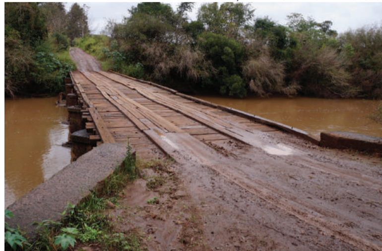
Atual ponte no Rio Buricá na divisa entre os três municípios
