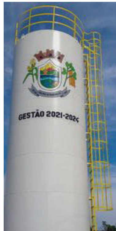
Reservatório tem capacidade de 60 m³
