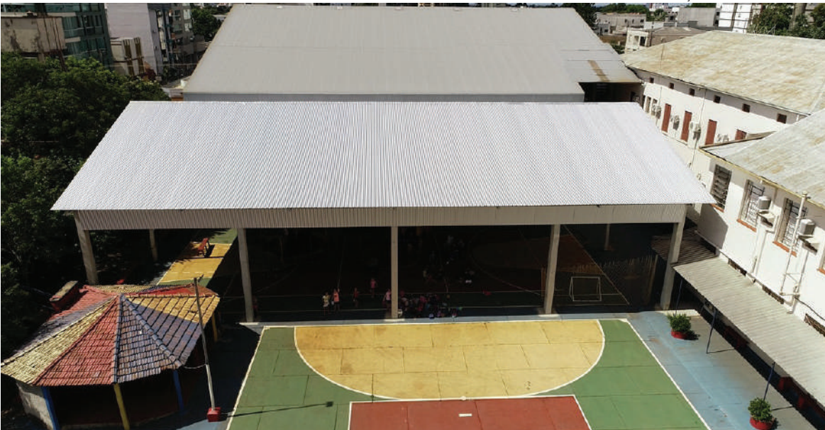
Dom Hermeto investiu na cobertura da quadra de esportes para as aulas práticas de educação física e instalou sistema fotovoltaico para atender demanda da escola
