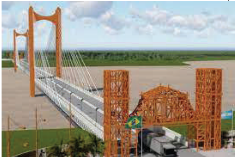
Maquete eletrônica do projeto da ponte que será construída sobre o Rio Uruguai entre Porto Xavier e São Javier. Ponte terá 900 metros de extensão, com largura de 16 metros e altura de 18 metros
