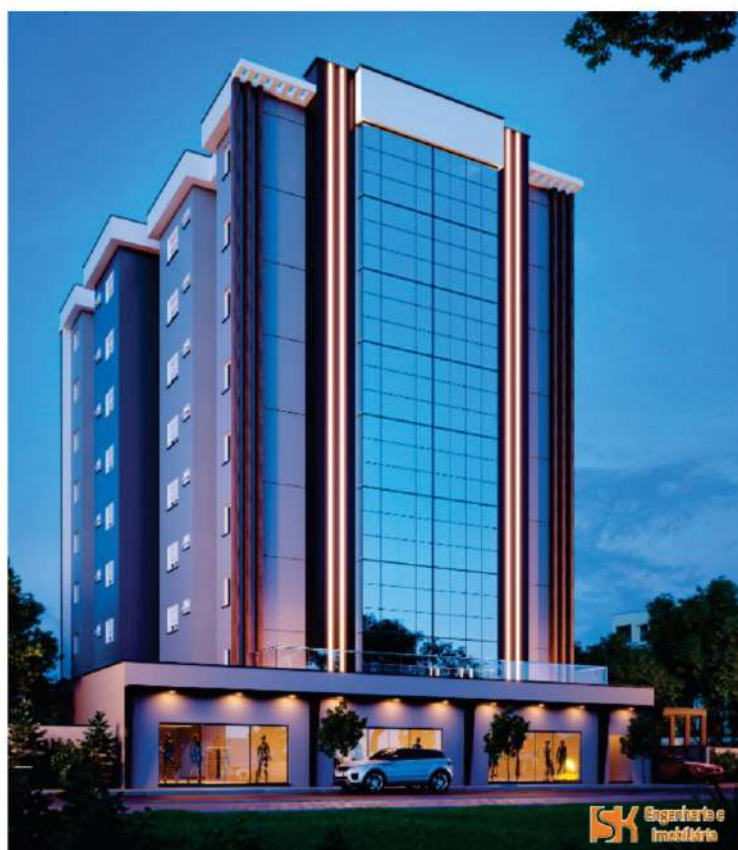
EDIFÍCIO MARIANA EM HORIZONTINA
