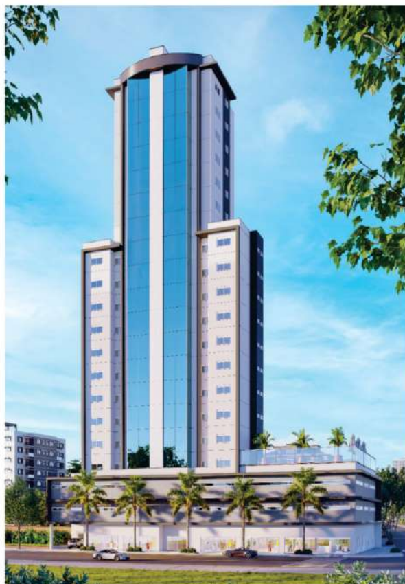
EDIFÍCIO FUSION EM TRÊS DE MAIO
