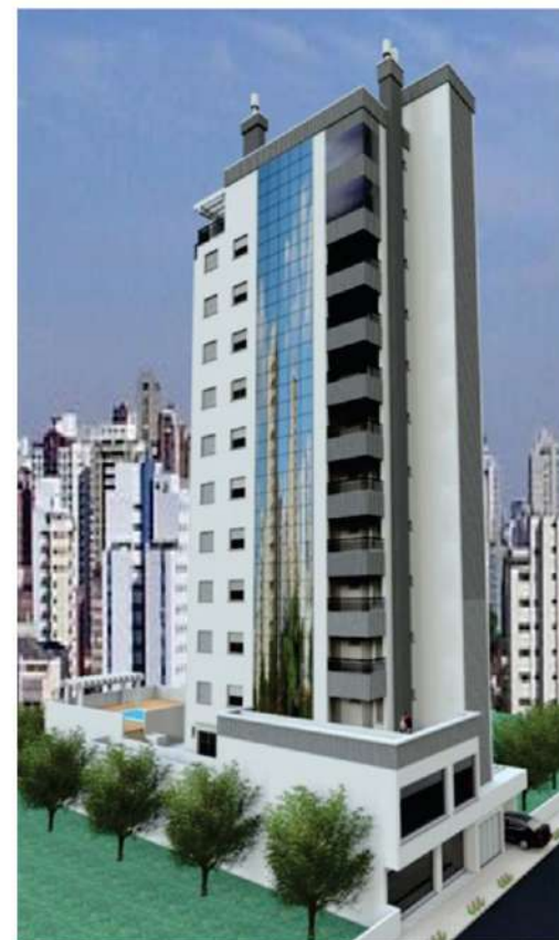
EDIFÍCIO PANORAMA EM TRÊS DE MAIO
